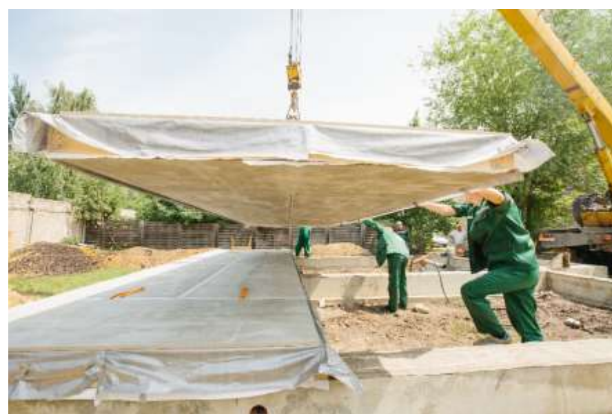
2. Монтаж цокольного перекрытия
