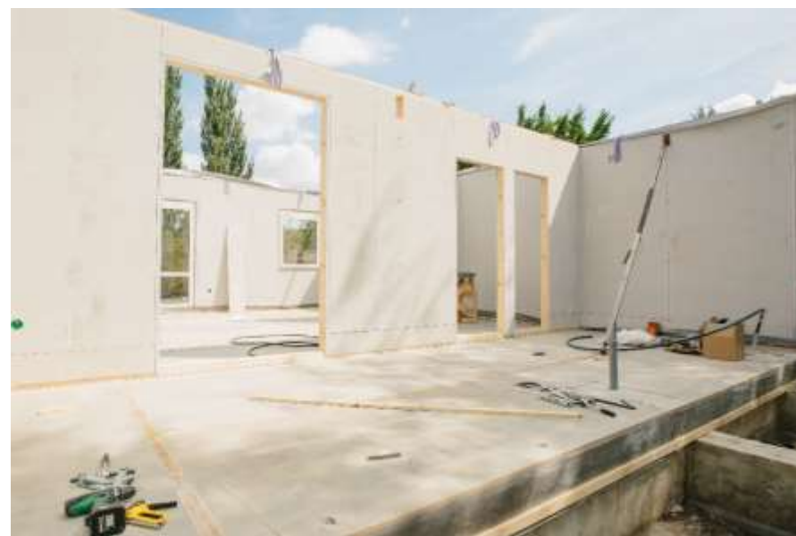
4. Монтаж межэтажных плит перекрытий
