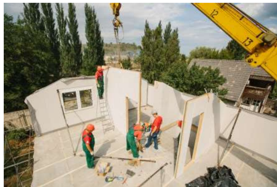
5. Монтаж стен второго этажа
