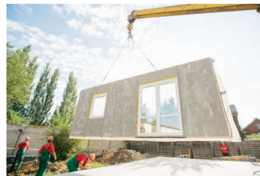
3. Монтаж внутренних и наружных стен
