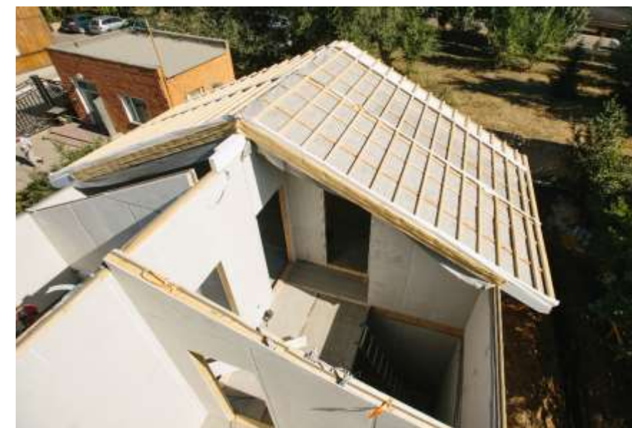
6. Устройство кровельных панелей
