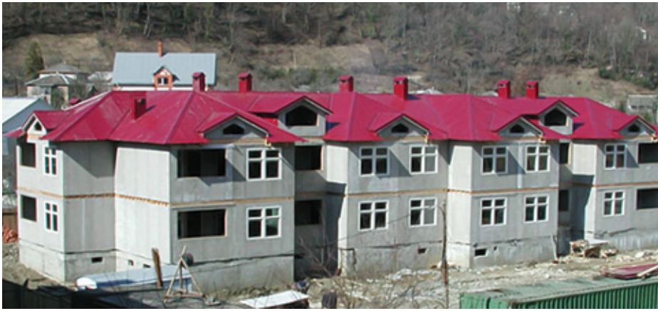
Дом с использованием обшивок из ЦСП
