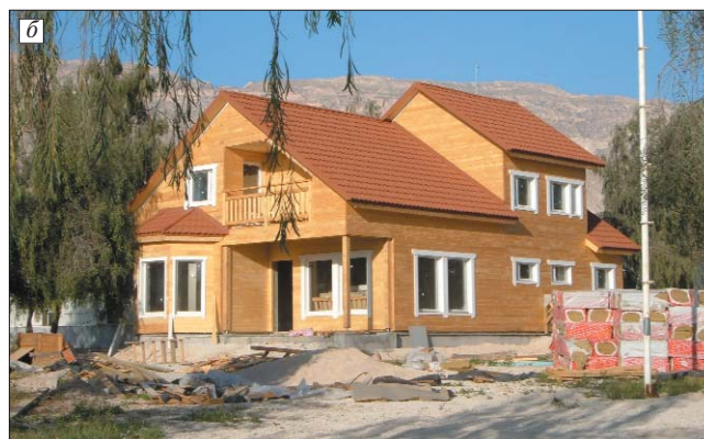
Рис. 2. Каркасно-панельный дом с использованием ЦСП ТАМАК в Иране: а – в процессе строительства; б – после окончания отделки
