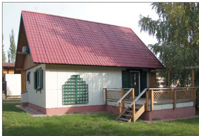
Рис. 6. Вариант отделки дома системы Макудом с использованием ЦСП
