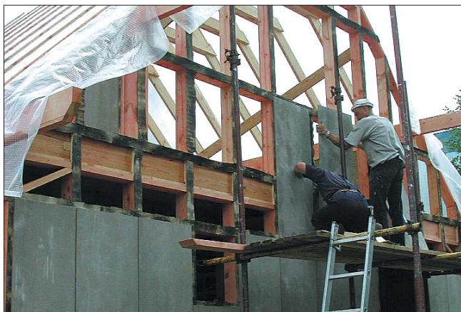
Рис. 5. Обшивка каркаса цементно-стружечными листами
