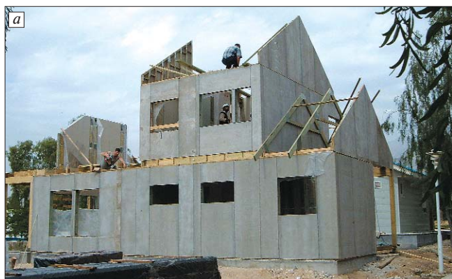
Рис. 2. Каркасно-панельный дом с использованием ЦСП ТАМАК в Иране: а – в процессе строительства; б – после окончания отделки
